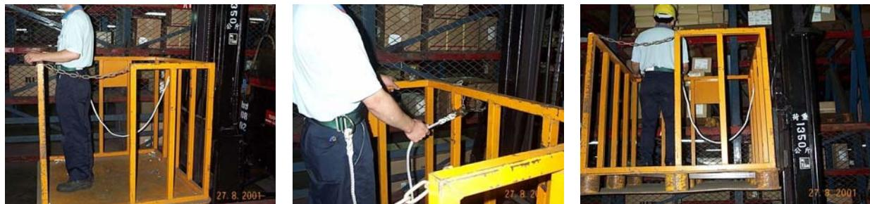
**(六)堆高機駕駛就定位，並開始徐緩上升作業：**駕駛人員應確認堆高機已於行駛停止狀態，並拉手煞車固定車身後，方得進行操作腳叉上升或下降，絕對禁止堆高機於行進間同時一邊操作腳叉昇高或下降。
